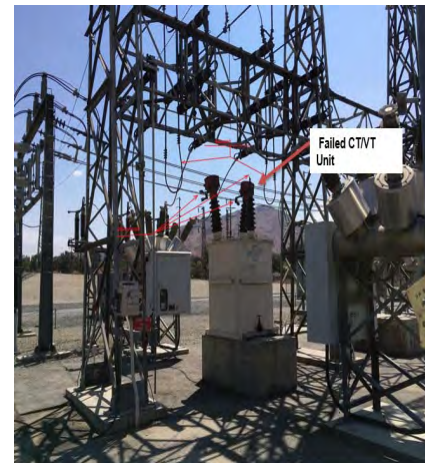
69kV Metering PT - SCE Vista Substation
