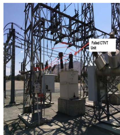
66kV Metering PT - SCE Vista Substation
